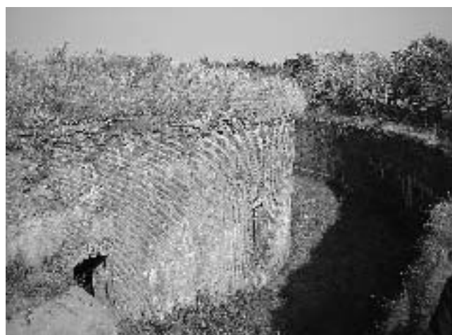
Kasematten und Wallgraben auf der Festungsinsel Langlütjen II. Foto: Thomas Kruse.
